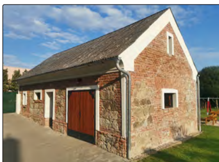
Opravená dílna za školou
