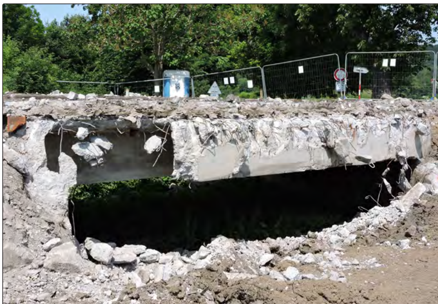
Rekonstrukce mostu přes záplavové území na silnici z Veletin do Hradčovic. Původní most byl postaven v roce 1932.
