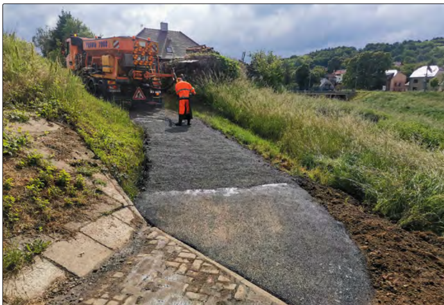
Zpevňování podjezdu pod mostem
